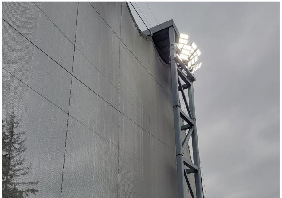
labilen Untergrund schwer fixierbar waren. Nach intensiven Evaluierungen wurde ein Projekt zur Konzeption und Montage einer Windnetzanlage mit 2.700 m<sup>2</sup> Netzfläche gestartet. Nach den Winterspielen im Februar 2014 wurde die Anlage abgebaut, um sie nachhaltig einer Wiederverwendung auf einer fixen Sprunganlage innerhalb der russischen Föderation zuzuführen.
